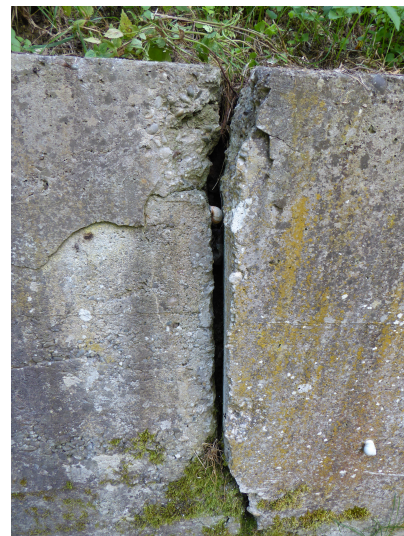
Mauerabbruch Quelle I
