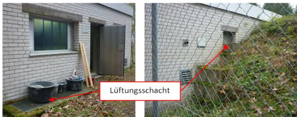
**Abbildung 6-4: Glasfenster und Lüftungslamellengitter. HB Irslingen**
