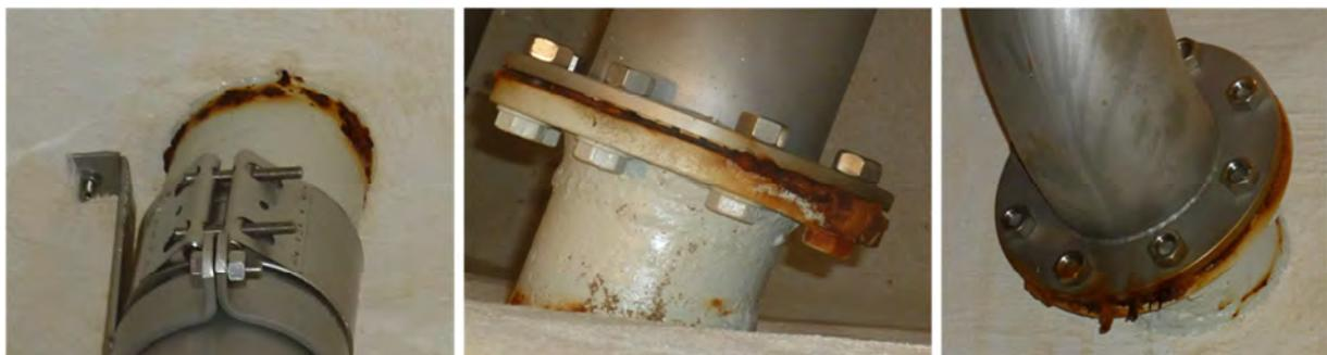
**Abbildung 6-10: Korrosion im Bereich der Hydraulik. HB Dietingen**
