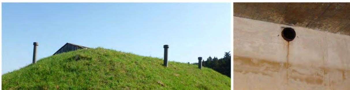
**Abbildung 6-12: Lüftungskamine; Be- und Entlüftung in der Behälterkammer. HB Böhlingen**
