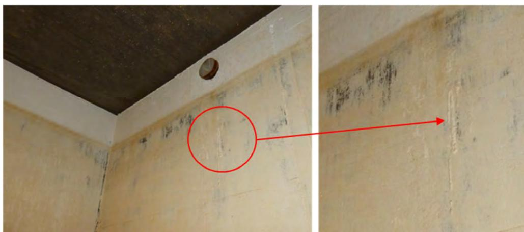
**Abbildung 6-8: Abrieb des Anstrichs und Kalkaussinterungen an Wandfläche. HB Lauffen HZ**
