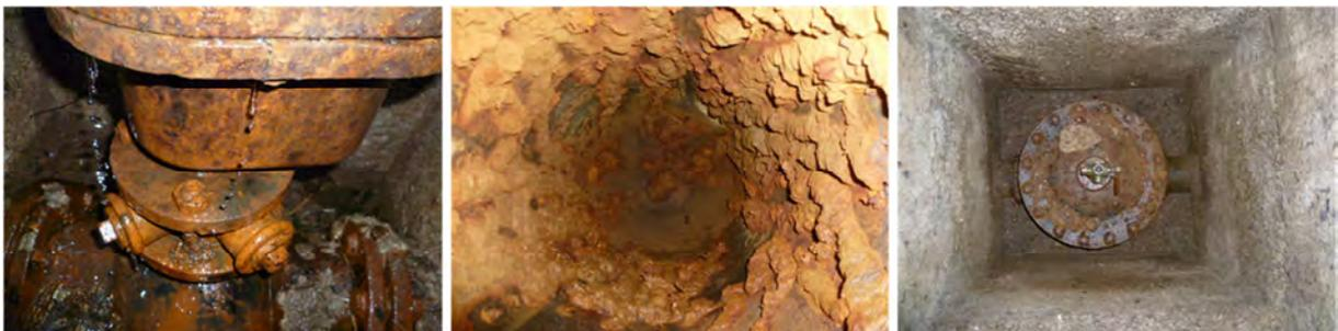
**Abbildung 6-16: veraltete hydraulische Installation in Schächten I**
