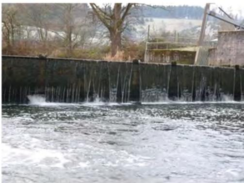
Abbildung 6-2: Undichtigkeiten Wehranlage
