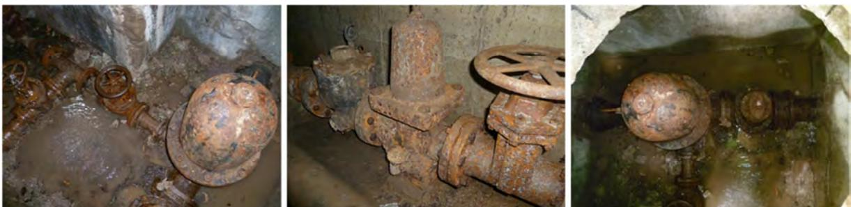
**Abbildung 6-17: veraltete hydraulische Installation in Schächten II**
