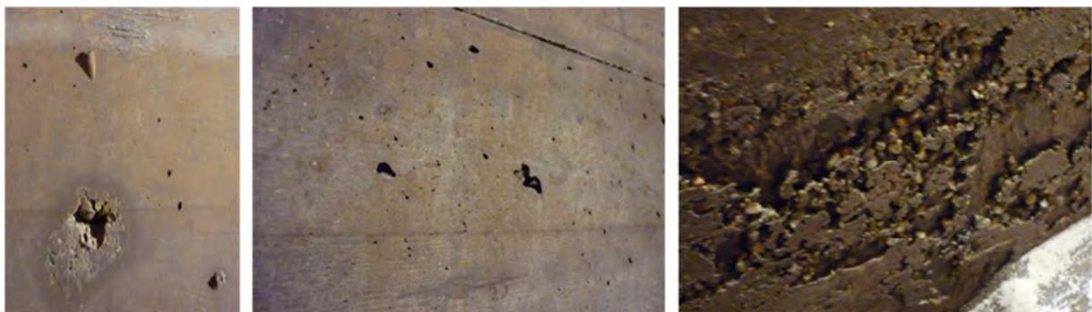
**Abbildung 6-6: Poren, Lunker und Kiesnester. HB Gößlingen**
