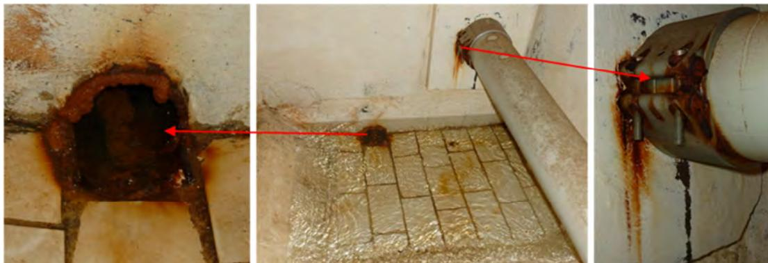
**Abbildung 6-11: Korrosion im Bereich der Hydraulik. HB Lauffen HZ**
