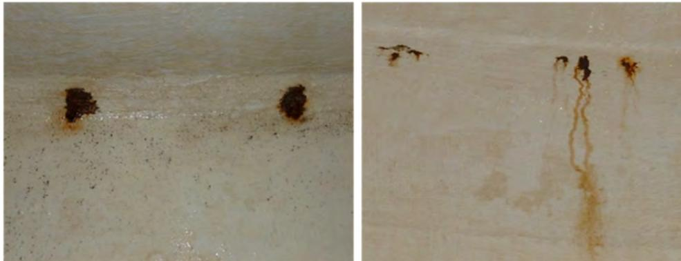
**Abbildung 6-9: Korrosionsstellen an Wand und Boden. HB Dietingen**
